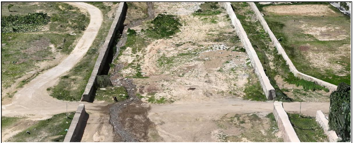
图 4-4 1#桥现状漫水路
