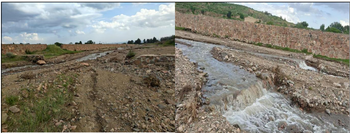
图 4-5 河道现状固河坎冲毁严重
