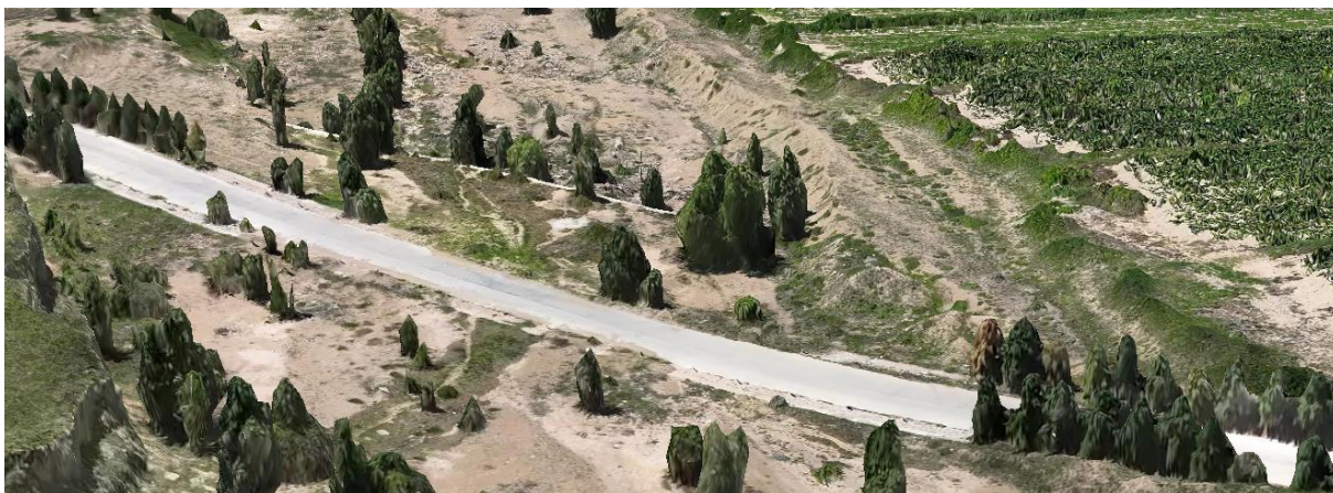
图 4-6 2#桥现状漫水路
